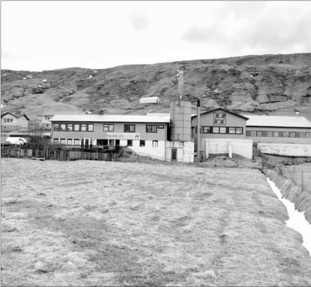
Snikkaðir virkir í Vatnsørum eru við at brenna inni við lidnum vindeygum, eins og hálvliðug vindeygu standa og biða eftir glasi, sum strandað er orsakað av verkfallinum, sum hevur lagt Strandfaraskipini
