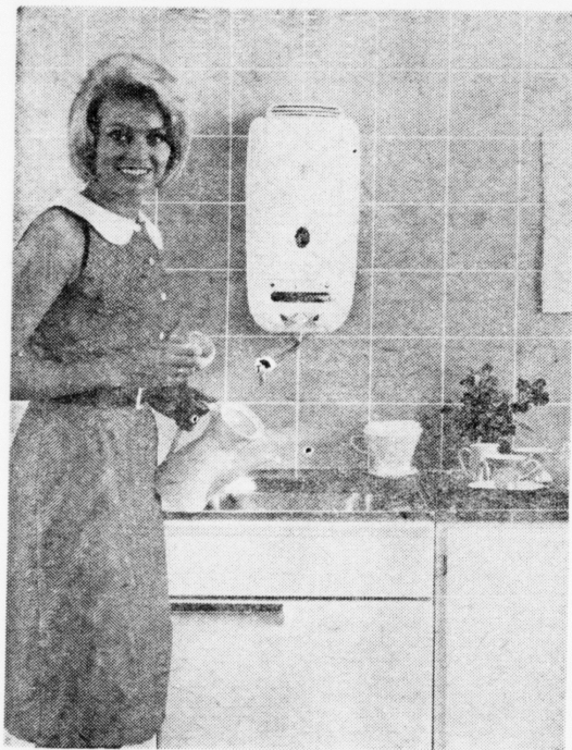
Lille og stor vandvarmer. Som det ses af billedet er der ikke noget aftræk fra den lille vandvarmer.
