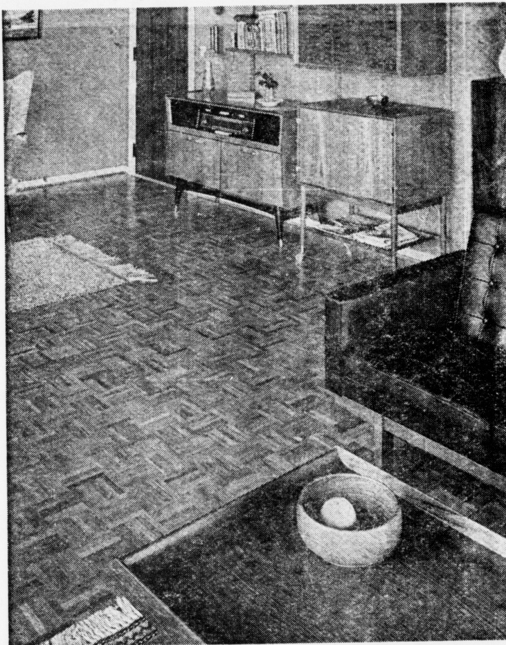
BW parket består af små lameller af egetræ, der er limet sammen i kvadrater og nedlægges som sådan. Efter nedlægningen afslibes gulvet og lakeres
