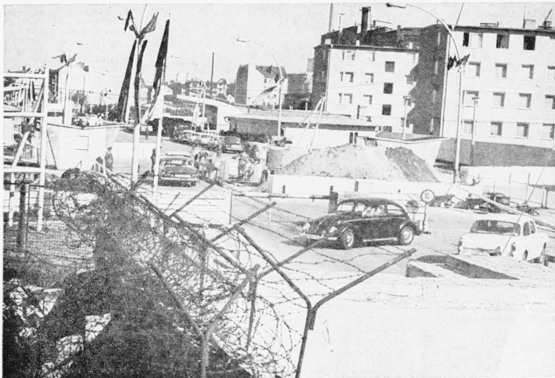
Jerntæppet midt gennem storbyen — overgangen ved Heinrich Heine-Strasse, som skulle blive overflødig i 1971
