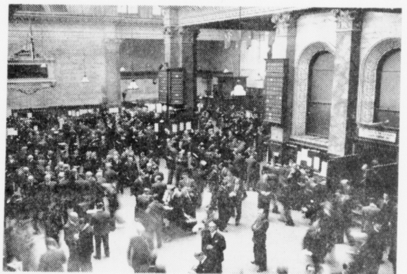
Stórar figgjarkeppur herjaðu seinastu árin, og Breiðland noydd ist at skera pundsvirðið niður. Á myndini siggja vit »Børsin« í London, har nógvar av teim álvarsonu hendingunum fóru fram.
