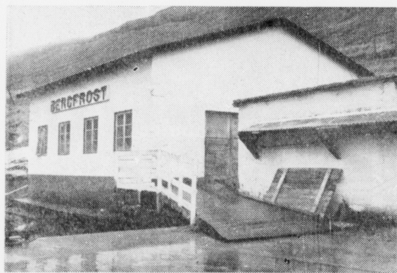
Flakavirkið Bergfrost í Árnafirði
