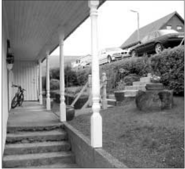
Hesi húsini standa í Saltangará. Aaneslands-stólpar eru undir úthanginum, og lægri stólpar eru júst settir upp við trappuna.
