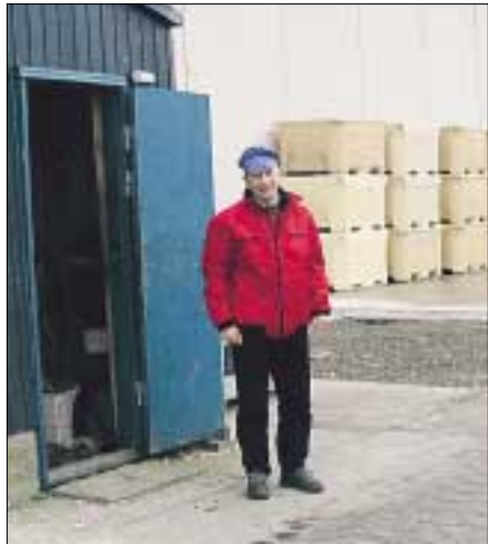
Johan Mørkøre við nýggja bygningin, sum Faroe Salmon og East Salmon hava latið byggja. Virkið fer at rúma mest framkomnu útgerð til kryvjing og pakking av laks.
