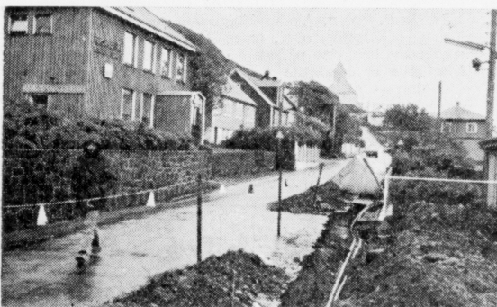
Í samband við flytan frá gomlu til nýggju stöð er nógv kaðalarbeiði farið fram í sein astuni.
