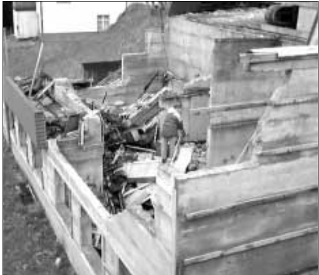
Nýggi bygnurin kemur at standa á sama staðið, har tann nú niðurbrendi bygningurin stóð. Í farnu vikuni fóru menn undir at ríva allan tann gamla bygningin niður
