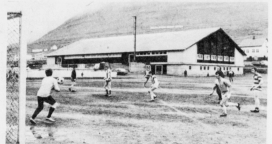
Leikvøllurin í Klaksvík og itróttarhøllin — arbeiðið við svimjuhøllina fer fram eystanfyri (vinstrumegin) itróttarhøllina
