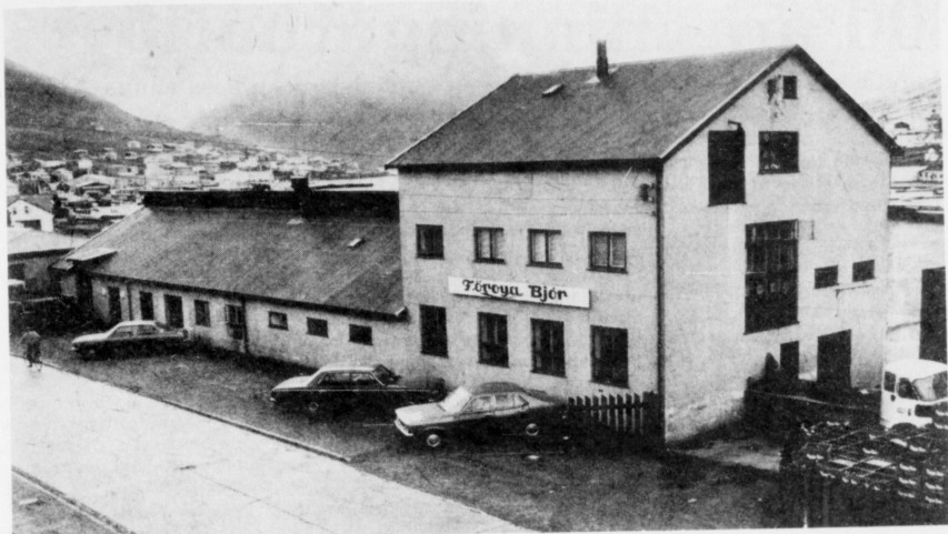
Bryggjaribyggingin, sum varð bygdur í 1952 — aftanfyrir høgurmeigin sæst ein partur av útbyggingini, sum verður framd nú
