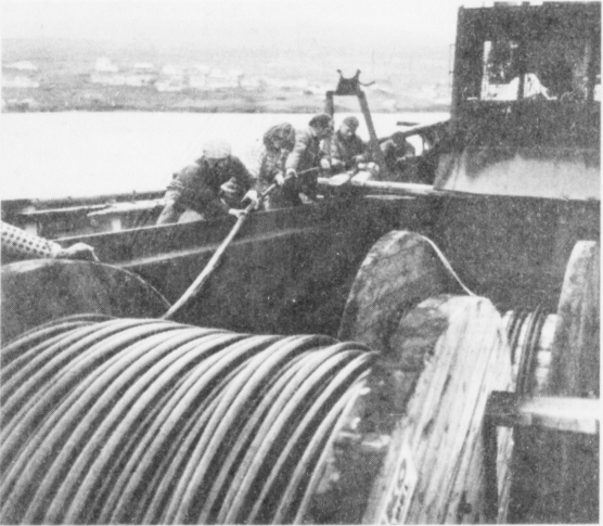
I lastini á sandbatinum siggjast kaðaltrumiurnar, ið vega upp til 12 tons stykkið
