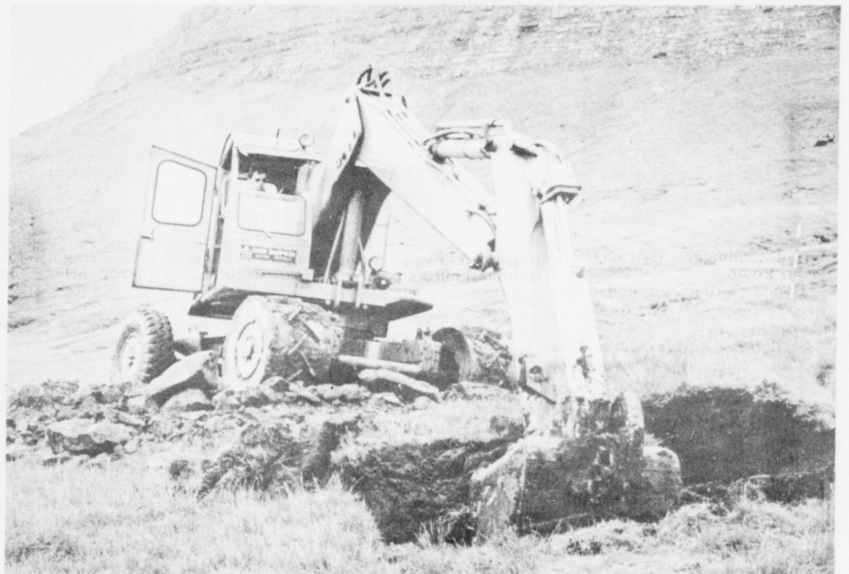
Teir hava eina gravimaskinu til veggerðina á Kalsoynni
