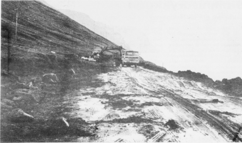
Lendið, har vegurin verður gjørdur, er bleytt og djúpt, og hevur tí verið nógv at grivið burtur
