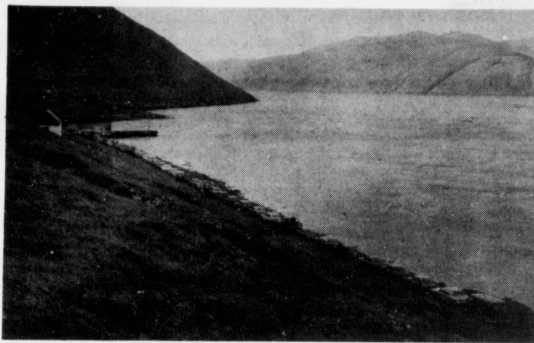
Ferjulega er bygd við Oyragjógv. Í oynni er annars bygging í gongd í Sandavági og Sørvági, meðan nærur er greitt í Miðvági
