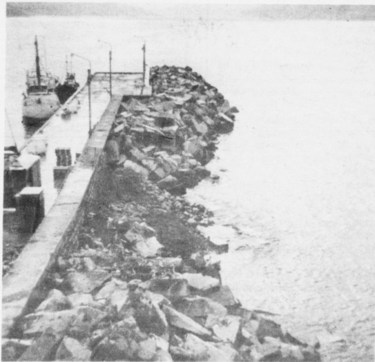
Á Eiði nýttu teir pelar úr »Hard Wood« til piersiðurnar. Síðan bleiv styrkt við grótkasti
