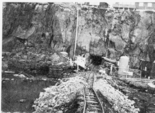
Kloakktunnellin sum grivin er undir »Trøð« skal eisini figgjast burtur av tiggju milj. láninum
