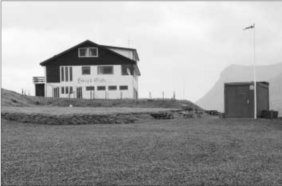
Nýggja tjaldingarplássíð á Eiði er nú klárt at taka í móti fyrstu gestunum. Tað liggur vestan fyrí Hotel Eiði. Bygningurin høgumegin hýsir wc, bað og turkirúmum Mynd: Edvard Joensen
