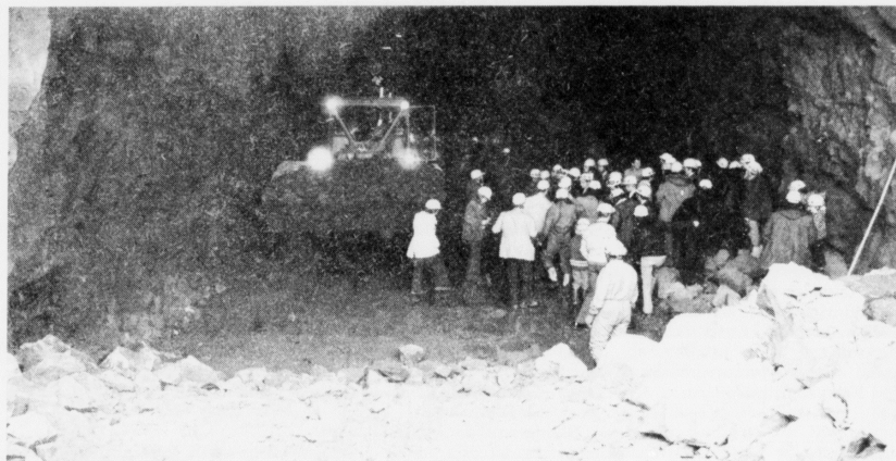
Aftan á tað seinasta skotið varð farið at rudda burtur við gravimaskinum
