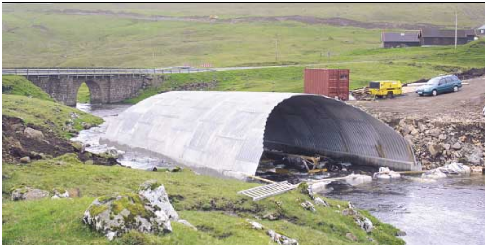
Ein nýggj brúgv um Sandá við Norðasta Horn er partur av arbeiðinum við at gera nýggjan veg til Kirkjubø og Gomlurætt. Mynd: Jens Kristian Vang
