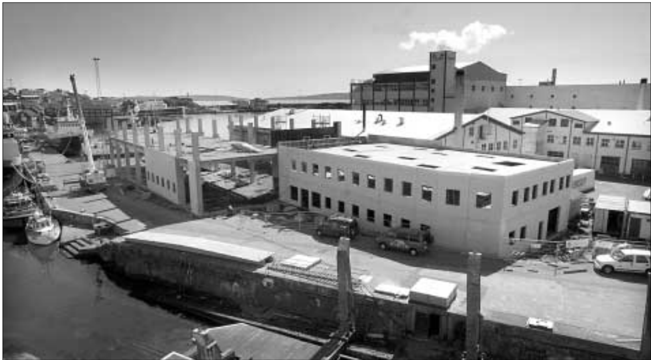
Tórshavnar Skipasmiðja ger nýggjan smiðju- og goymslubygning
