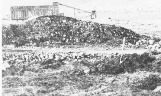
Ókið, har nýggja mjólka- og margarinvirkið skal byggjast
