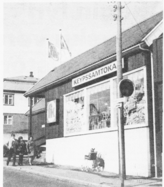
Núverandi Keyppssamtøkubygningur í Havn
