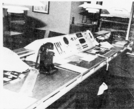
I kontrolltorninum á flogvøllinum
