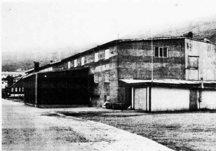
I hesum litla áfasta bygninginum heldur Roykivirkid til
