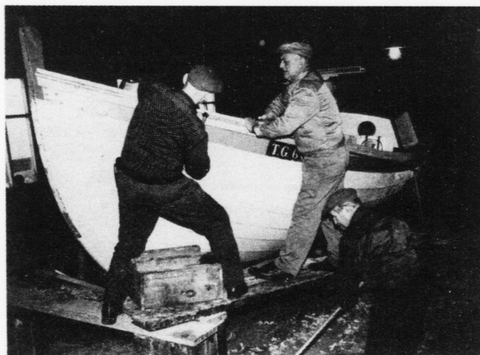
Teir leggja dekk í bátin hjá Niels Mørk. Henda bátin bygdu teir har á verkstaðnum fyri níggu árum síðani
