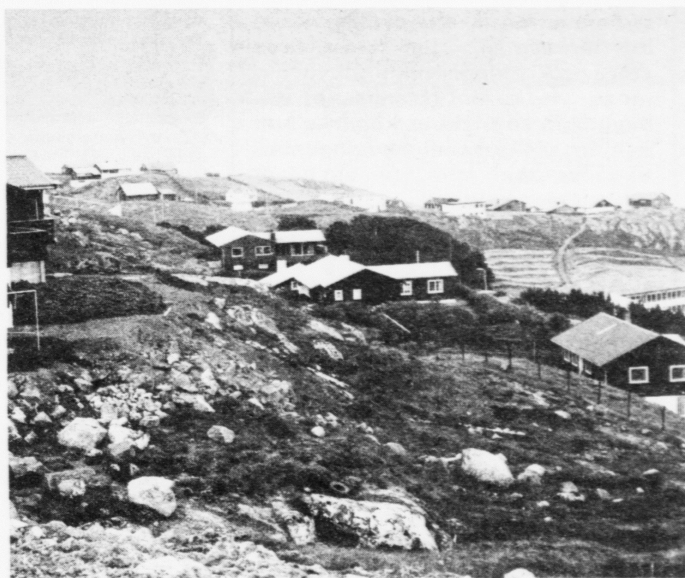
Trimannaráðið skal røkja allar vanligar kommunalar uppgávur, umframt at tað skal fáa heimild til at loysa ymsar aðrar kommunalar uppgávur í Hoyvík og á Hvítanesi
