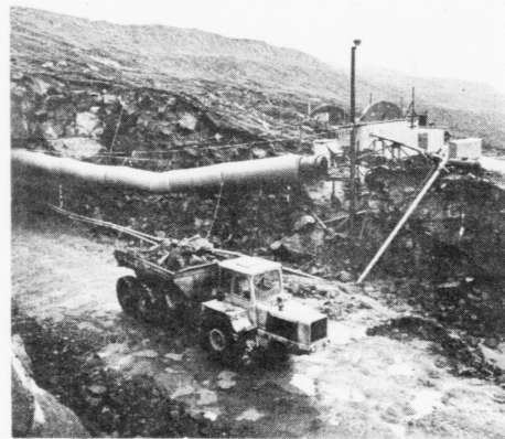
Arbeiðseftirlit vil hava reglur fyri nýtslu av spreingievni í sambandi við tunnulsgerð
