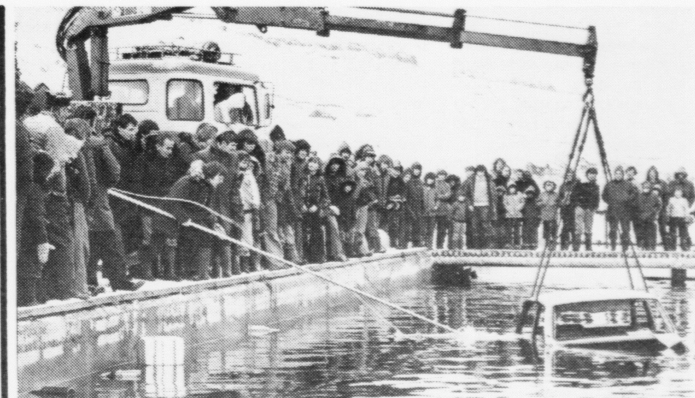
Landsfelagið fyri føroysku bjargingarfølagini hevði leygardagin eina framsýning í bátahylinum í Kollafirði. M.a. var ein bílskutill royndur. Skutilin er gjørdur til at gera fast á bilar, sum eru farnir á sjógv. Skutilin fer 14 cm inn. Úrslitið av royndunum við skutilinum var gott... Jákup Alberg Berg hevur tikið myndina.
