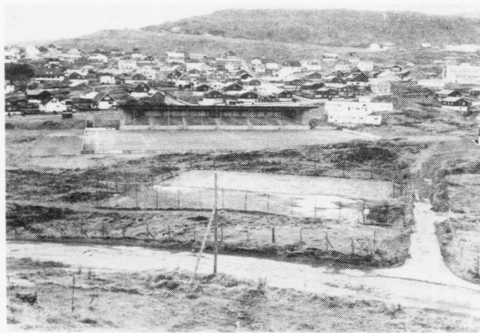
Svimjihøllin skal byggjast, har sum tennisvøllurin nú er. Í hesum fíggarári eru 8 mill. kr. settar av til arbeiðið. Í 1976, tá býráðið samtykti at fara undir detaljprojekteringina, var kostnaðurin mettur til 10 mill. kr. Nú verður hann í minsta lagi 23 mill.
