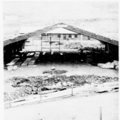
Høllin avmyndað stutt eftir, at sjálv byggingin varð byrjað einaferð í fjørsummar
