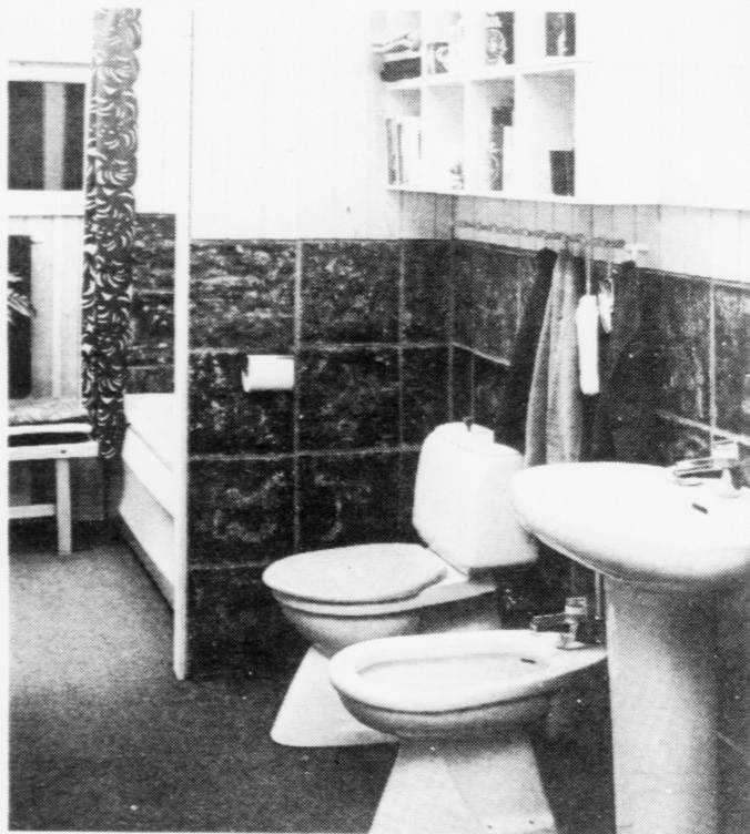
Træ kann eisini nýtast í baðirúminum. Tó er tað ráðiligt at halda tað eitt sindur frá støðum, har vatn slettir á. Í brúsunum eigur træið at vera minst 170 cm upp frá gólvi
