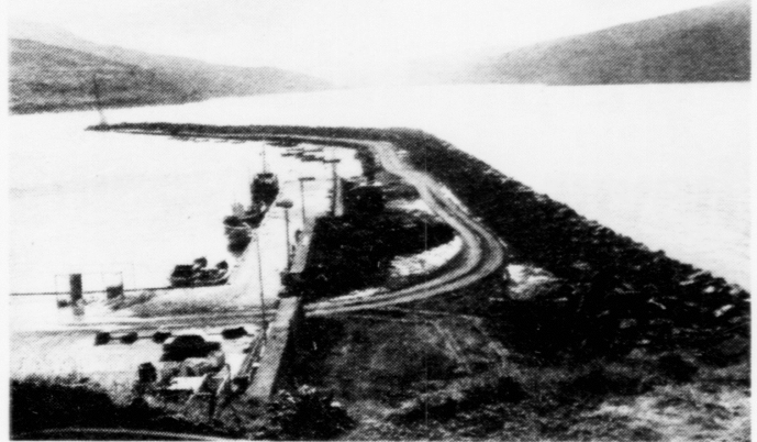
Vestari molin sæddur frá vegnum nærhendis flakavirkid. Nú skal stórt grót leggjast omaná og innanfyri. Atløgubryggjan verður ikki gjørd í hesum umfarinum
