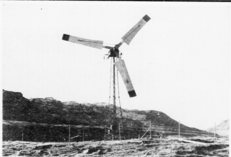
Varð myllan sett upp í dag høvdu teir ikki ivast í at sett hana upp heilt uppi á sjálvari fjallarøðini, sum er eystanfyri Tvøroyri. Har hevði hon kunnað framleitt munandi meira av streymi
