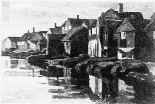
Soleiðis málaði Ingolfur av Reyni einaferð. Kend motiv og fjálgir og sterkir litir. Myndin kallast »Undir kjallara« og sýnir húsinu fram við Eystaruvág og út móti Tinganesi, soleiðis sum tað sá út fyrri Sjóvinnubankin bygdi
