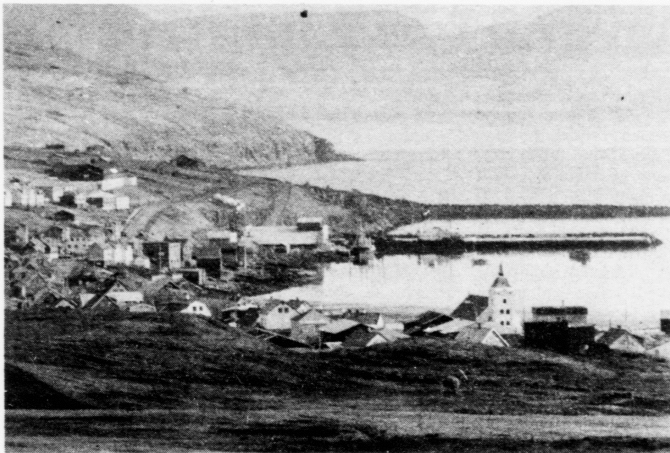
Míðvágur og Sandavágur hava felagshavn. Í ár er ætlanin at gera 100 metrar av atløgubryggju innanfyri báðar pierarnar
