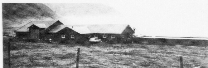
Fjósið, sum Louis Houmann fór at byggja í 1977, liggur á Fløðhamri
