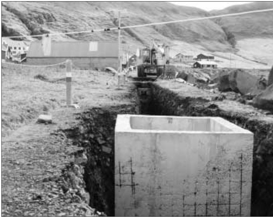
Farið er undir at gera kloaksskipanina í Fámjin. Í ár verður arbeitt fyri eina góða millión, og arbeiðið fer tilsaman at taka ein fyra ár, sigur borgarstjórin
