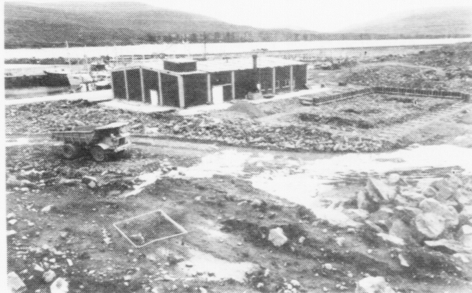
Flakavirkið á Sandi verður bygt beint vestanfyri fiskahúsið. Fyrstu formarnir vóru komnir upp, tá myndin varð tikið ólavsekudag
