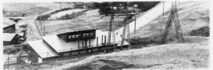
Vatnriksa hitapumpuanleggið í vakstrarhúsinum í Sandavági framleiðir í dag hitaorku til upphiting av vatninum í vakstrarhúsinum. Nú skal hetta anleggið útyggjast til eisini at framleiða streym, sum ætlast koyrdur inn á elnetið hjá SEV
