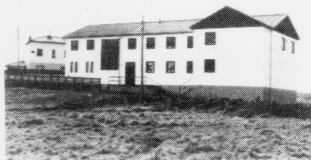
Fyri nokrum árum síðani varð húsið hjá ungmannafelagnum Virkinum útbyggt fyri eina mill. kr.
