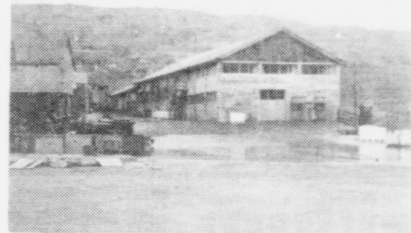
Flakavirkjó Norðis á Eiði gongur á 17 ári. Tað er órationelt og skal tí umbyggjast og møgulega útbyggjast
