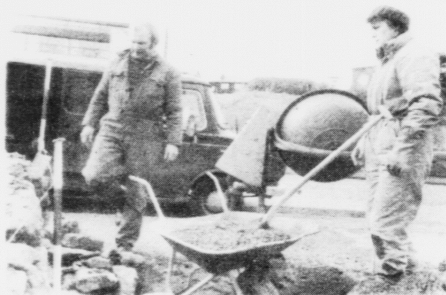
Arbeidsreidskapurin er ikki nýggjastu teknilogisku tólini, men bert ein hjólbæra, blandimaskina til sement, setthamar o.á.
