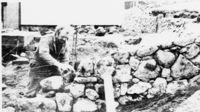
Gudmund Guðmundsson, grótlagari í arbeiðinum við at laga ein grótgard. Annars hava bæði systkini eisini til uppgávu at laga grótrappur, klæða trappur við gróti, gera urtagarðar o.á.
