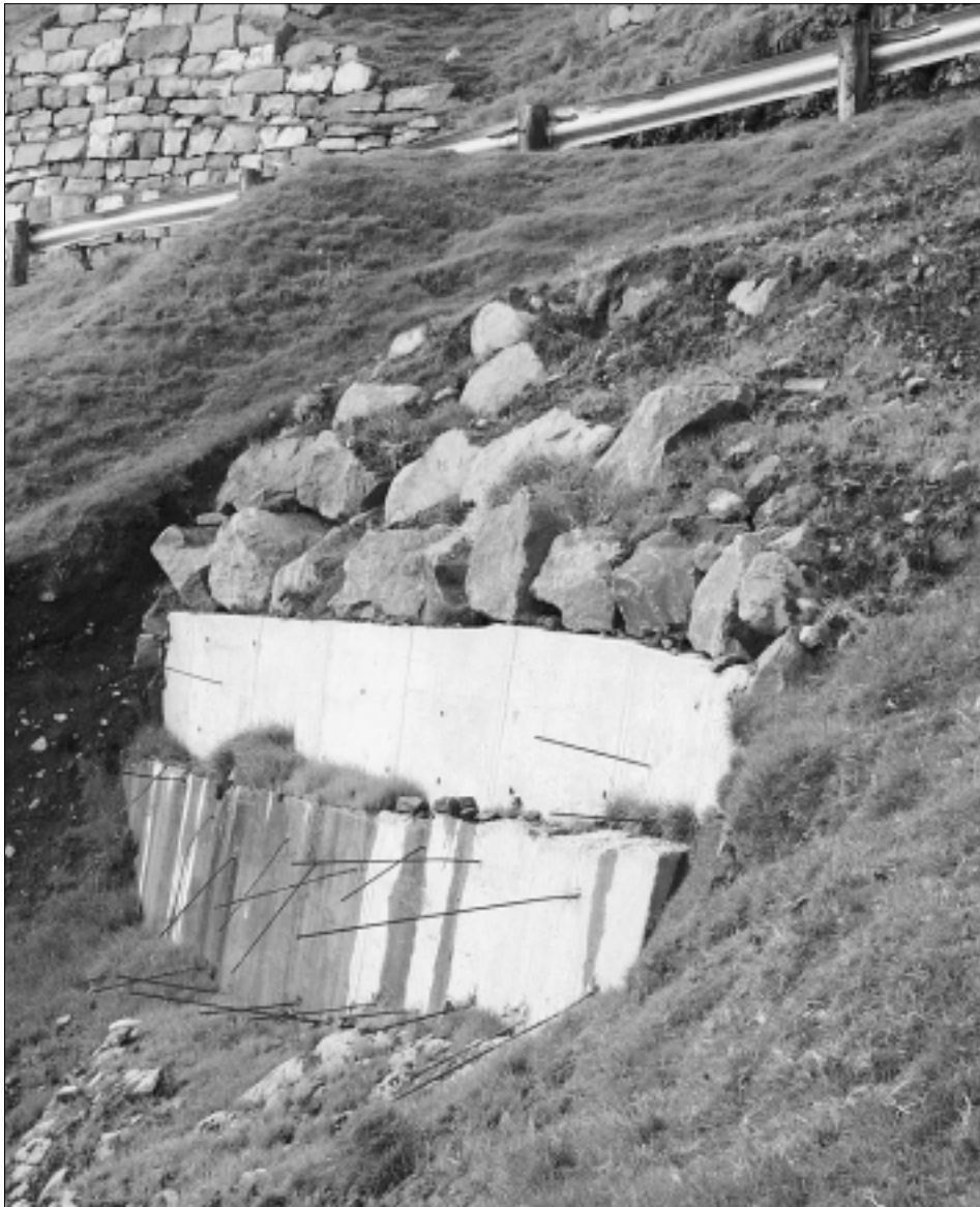
Eftir eitt lop í vár, varð stoypt og laðað upp undir vegkantin
