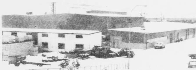
Tvøroyrar flakavirki aftaná nógv tiltrøngu útbyggingina. Eystursíðan
