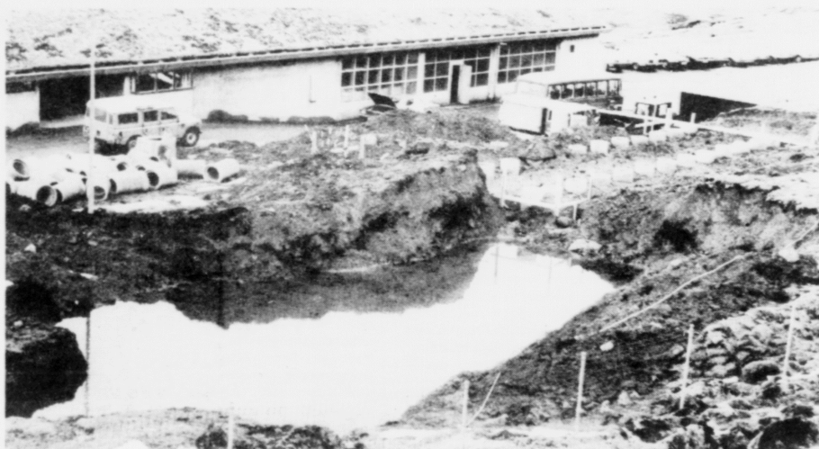
Her er ætlanin at tær nógv umrøddu barakkirnar skulu setast upp. Farið er undir útgrevsturin og farið er at gera fundament. Í barakkunum er ætlanin at handverkarar, m.a. útlendskir teknikkarar, skulu buggva, meðan tann umfevnandi útbyggingin — fyri 130 mill. kr. — fer fram
