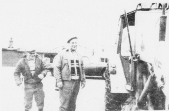
Kl. er eitt korter yvir fyra. Herluf Petur og Erling í gravimaskinuni eru við at gevast. Teir vóru í ferð við at taka asfalt av Vaglinum. Alt var í einum roki. Teir fingur tí lov at fara upp
