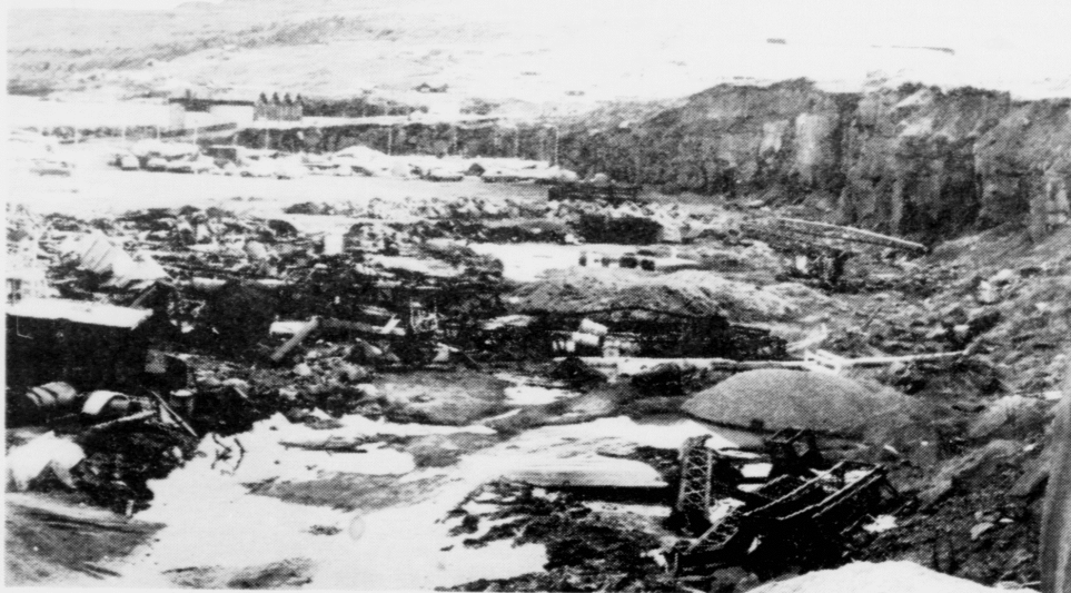
Her í Álakeri fer um stutta tíð at liggja eitt tað mest nútímans goðskingarvirkið í Føroyum. Virkið skal byggjast suður úr bátadráttinum og framvið berginum norður eftir
