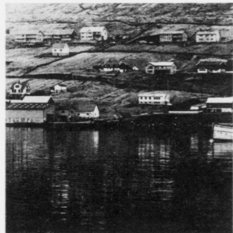
Ísvirkið í Fuglafirði sæst vinstrumegin á myndini
