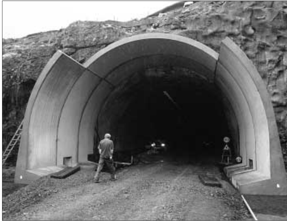
Farið er undir at gera portalarnar báðu megin undirsjóvartunnilin lidnar Mynd: Jens Kristian Vang
